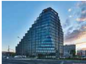
FA 50N HI, TM 77HI, TM 75EI, PBI 50N, YSP OFFICE BUILDING - BAŁTYK TOWER BAŁTYK TOWER - BUDYNEK BIUROWY POZNAŃ / POZNAŃ 14
