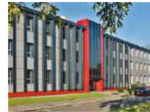
FA 50N HI OFFICE BUILDING - KUŹNIA POLSKA BIUROWIEC - KUŹNIA POLSKA SKOCZOW / SKOCZÓW 24
