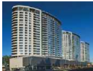
FA 50N, FA 50N EI, TM 74HI THREE TOWERS RESIDENTIAL ESTATE OSIEDLE MIESZKALNE TRZY WIEZE SLOVAKIA / SLOWACJA 57
